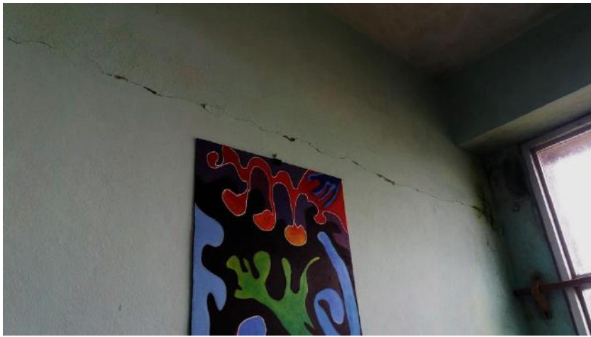
Paredes con hongos
