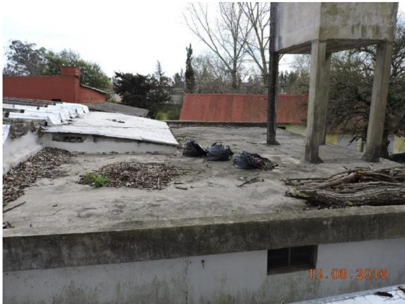
Uniones de techos y paredes fisuradas
