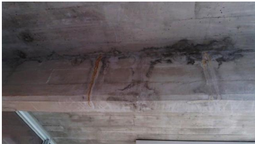
Filtraciones de agua en la planta lical
