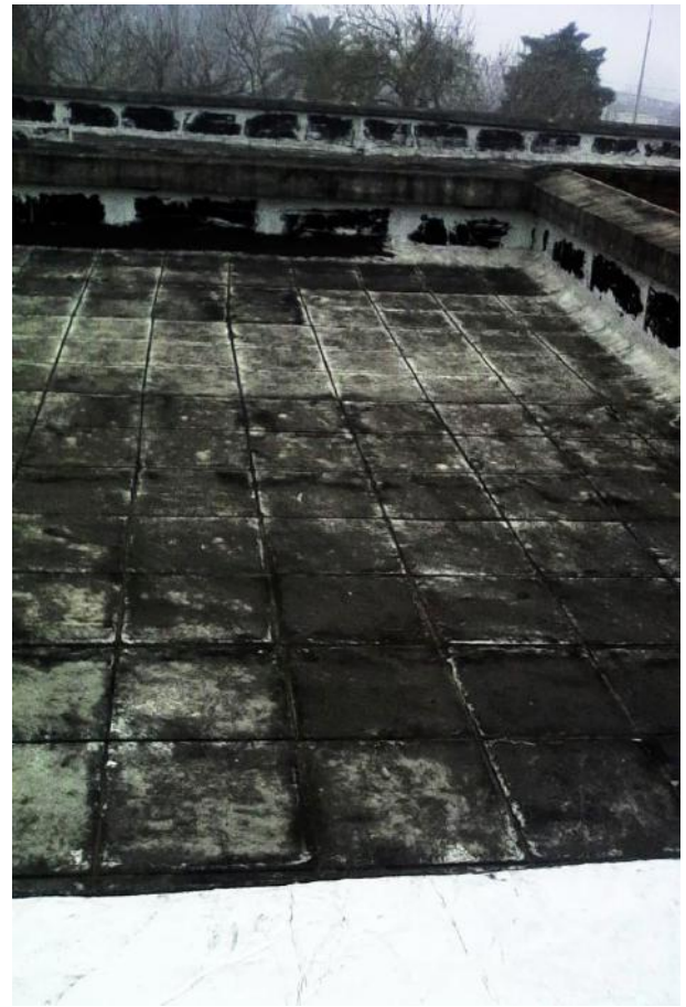
Filtraciones de agua en la planta lical
