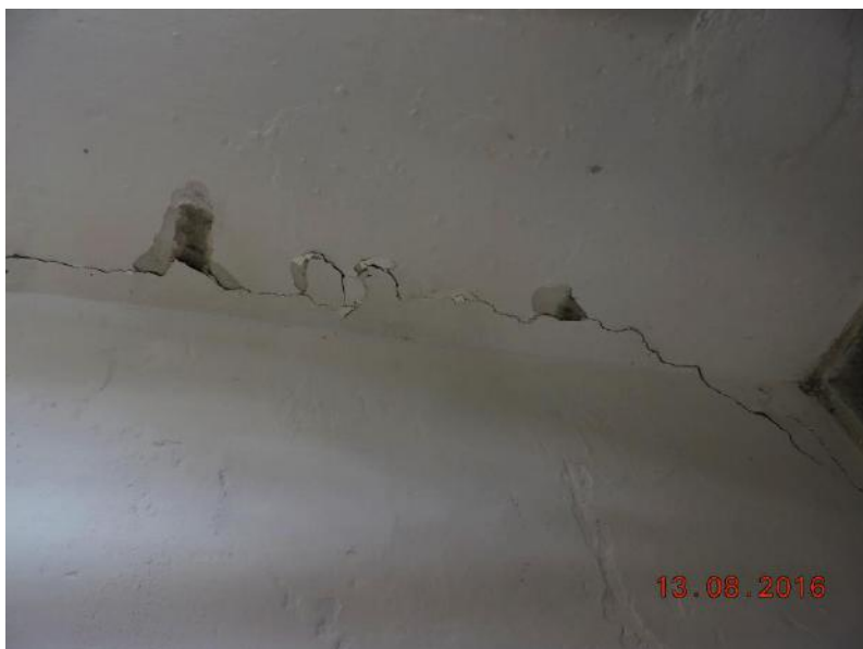
Uniones de techos y paredes fisuradas
