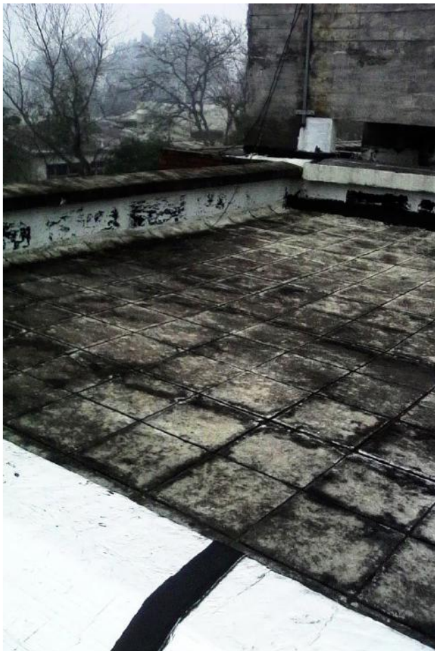
Azoteas de la planta liceal sin membrana protectora
