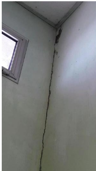
Paredes fisuradas
