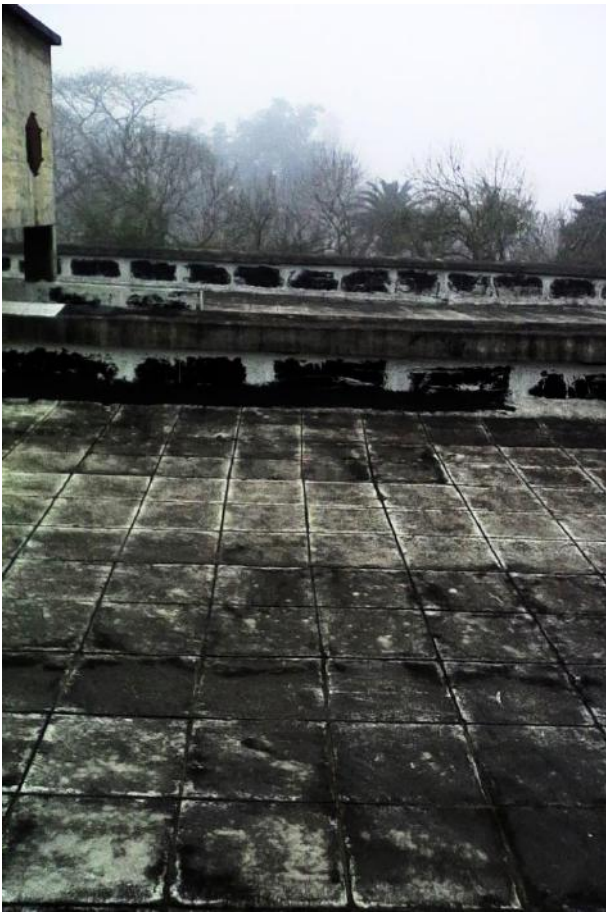
Filtraciones de agua en la planta lical
