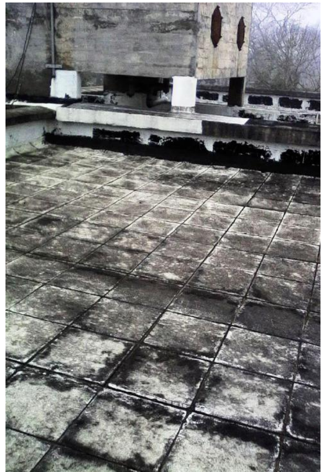
Azoteas de la planta liceal sin membrana protectora
