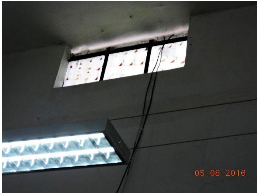
Tubos de luz sin protección mecánica
