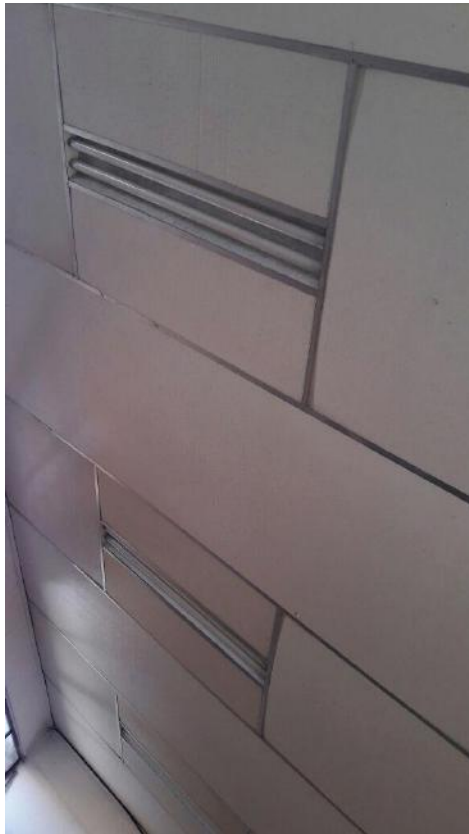
Tubos de luz sin protección mecánica
